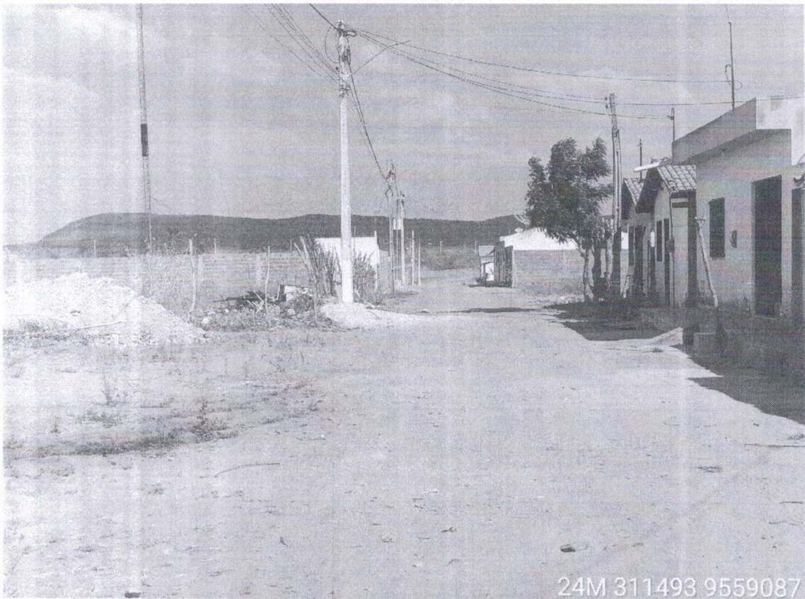
FOTO DO LOCAL DA OBRA
