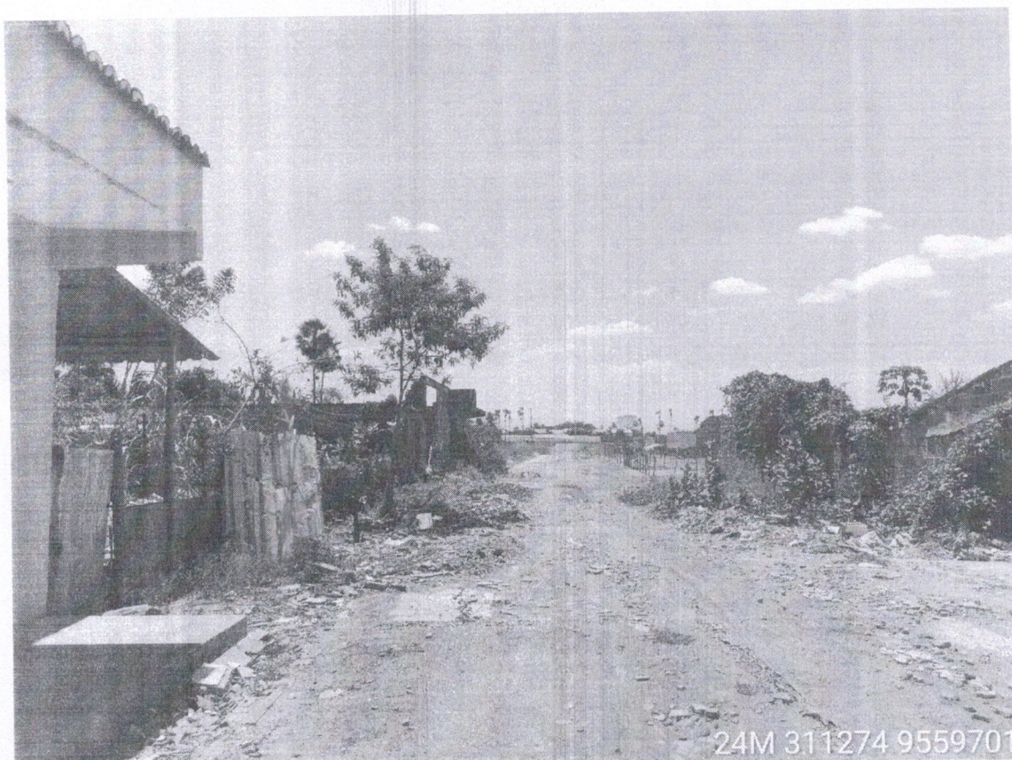
FOTO DO LOCAL DA OBRA
